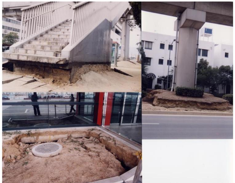
Fig. 1 1995 兵庫県南部地震の際の地盤沈下の様子を捉えた写真（ポートアイランド）
