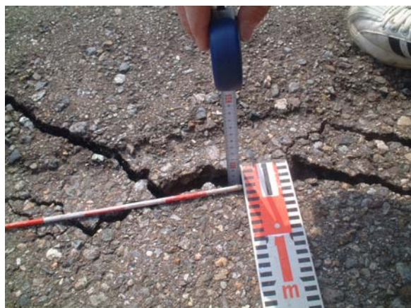
写真 3-7-7 縦-01 での路面クラック発生状況
